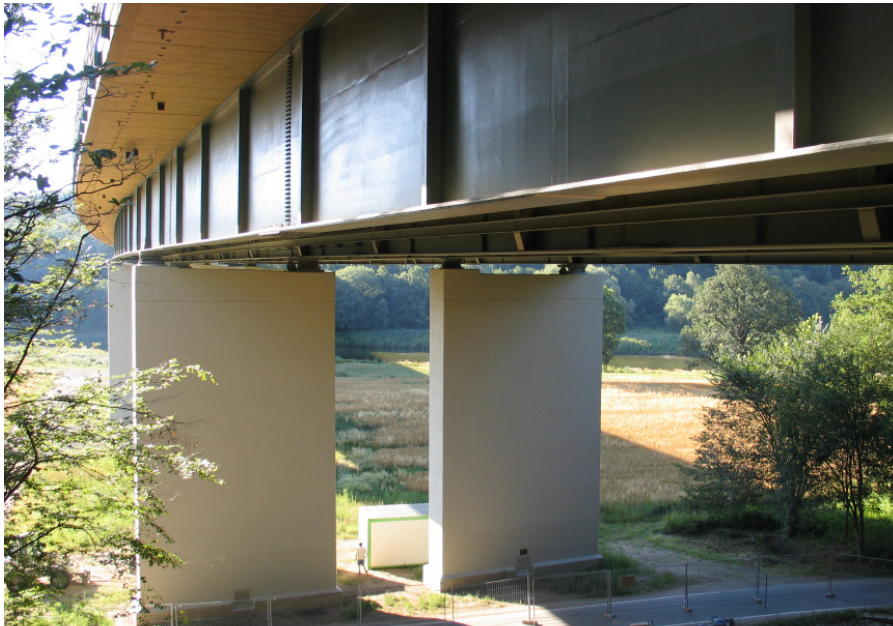
Blick von Widerlager Achse-0 auf Instand gesetzte Pfeiler
