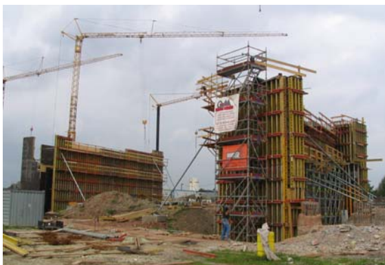
BW 49-2 Herstellung Rahmenstiele
