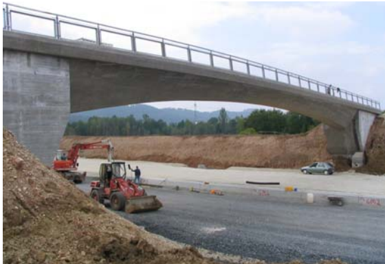
BW 48-5 im Zuge Streckenbau
