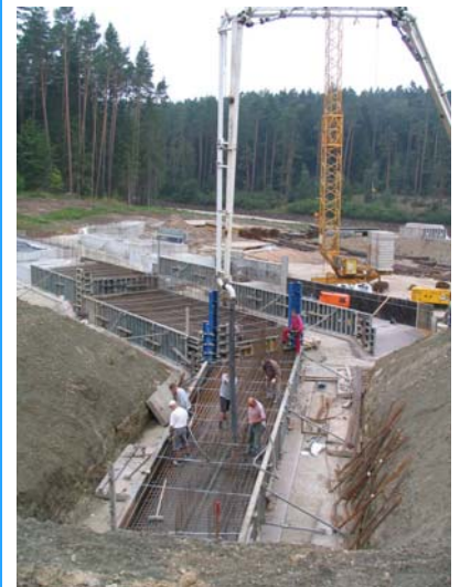
BW 51-5 Betonage Fundamente
