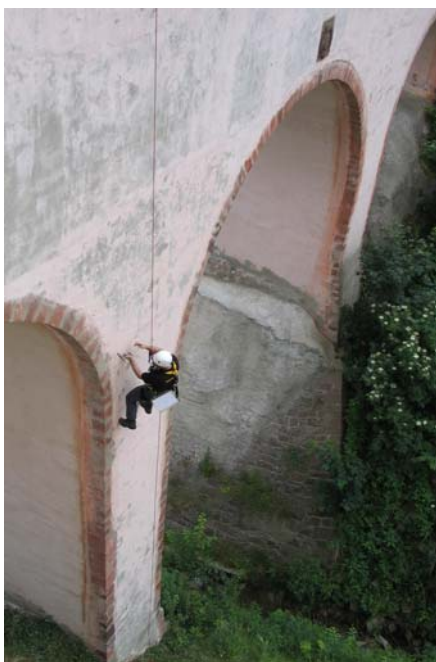
Pfeilerprüfung nach DIN 1076 (handnah)
